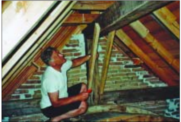
Josef Weickl beim Errichten des neuen Dachstuhls der Weingartenkapelle.
